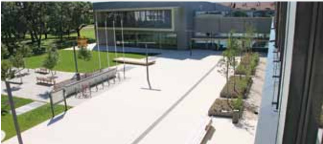
Abb. 10: „Angepasstes“ Rathaus Gilching (baulicher Überhitzungsschutz (außenliegende Verschattung), automatische nächtliche Querlüftung und Kühlung per Grundwasser)
